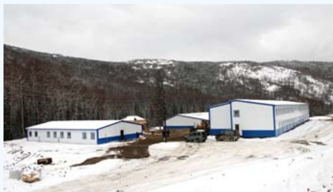
Вахтовый поселок, месторождение «Лунное»
