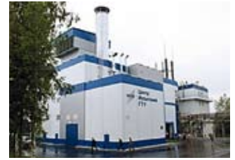
Испытательная установка ГТУ «Протон»
